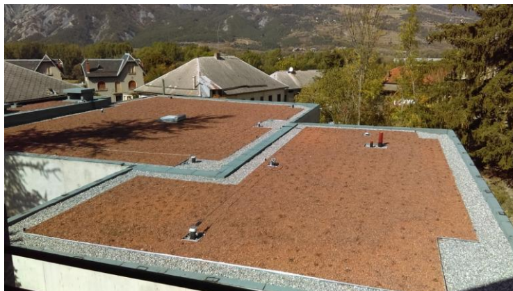
La toiture est réalisée et végétalisée avec des plantes grasses qui occuperont toute la surface du toit.
