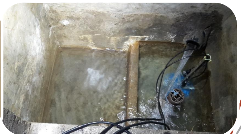
Capteur installé au captage
